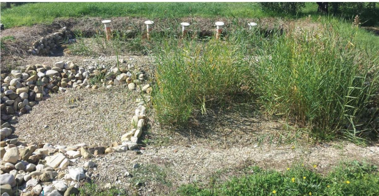
Foto 2: I due fitodepuratori pilota costruiti presso il Frantoio Santa Tea (in primo piano il fitodepuratore a flusso orizzontale)
